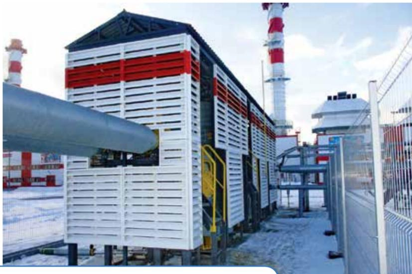
**Фото 9. Блок подготовки попутного газа для ГТУ-ТЭС Усинского месторождения**
