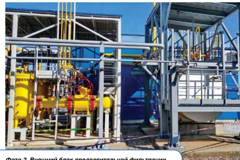
Фото 2. Внешний блок предварительной фильтрации и узел дренажа конденсата
