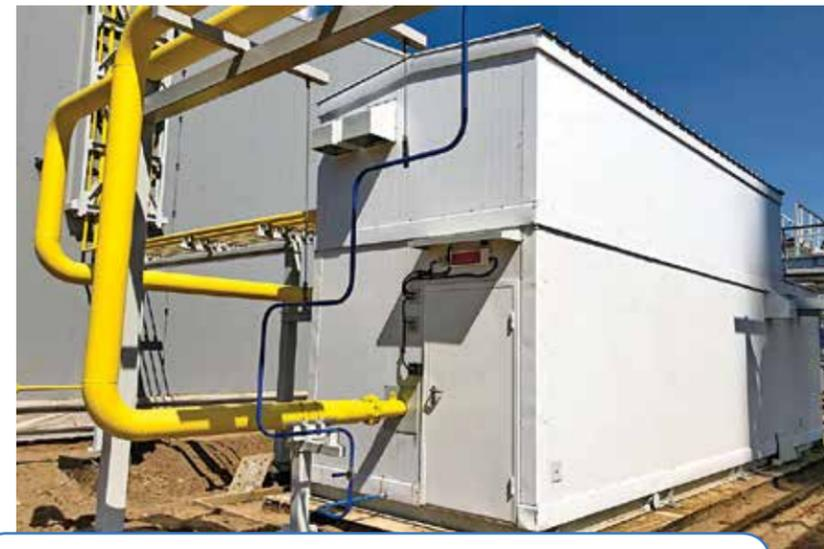
**Фото 10. Блочный пункт очистки газа для ГТУ-ТЭС в Елабуге - компактная установка в базовой комплектации**
