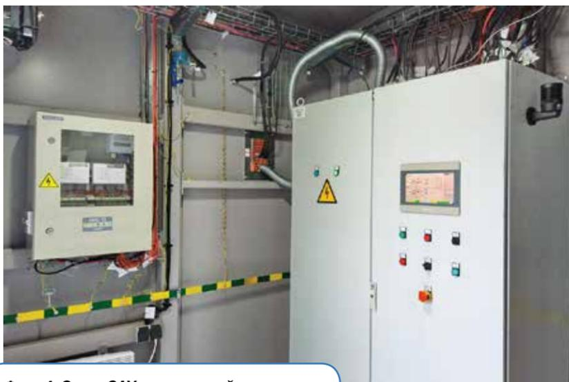
Фото 4. Отсек САУ комплектной установки
