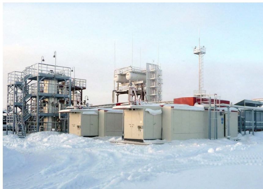
ФОТО 7. КУ в арктическом исполнении компримируют НН ПНГ в составе СКНС Северо-Лабатьюганского м/р (Сургутнефтегаз)
