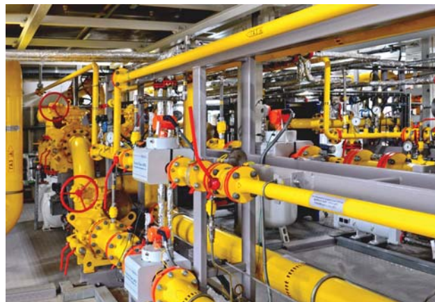
Фото 4. Узел коммерческого учета газа с ультразвуковыми расходомерами
