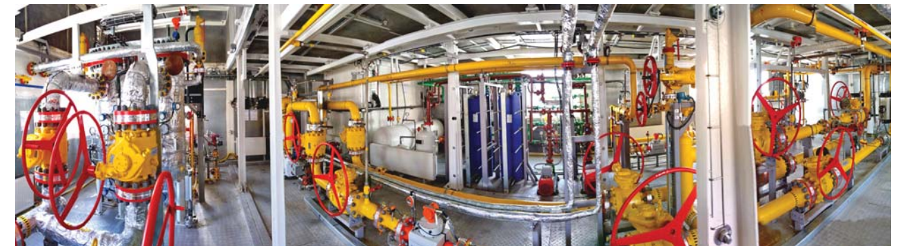
Фото 2. Отдельные блок-боксы при монтаже создают общее технологическое пространство многоблочной установки (панорамный вид)
