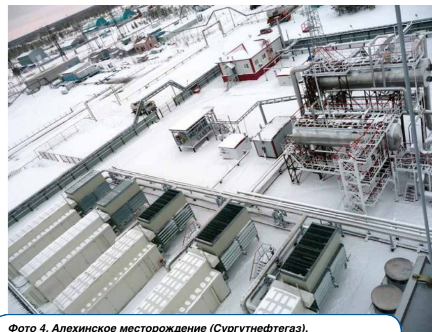
Фото 4. АLEXИНСКОЕ месторождение (Сургутнефтегаз). На компрессорную станцию низких ступеней сепарации поступает смешанный ПНГ из нескольких источников
