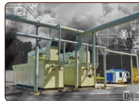
Рис. 3. Система комплексной подготовки газа «ЭНЕРГАЗ» для автономной ГПЭС завода микроэлектроники «Ангстрем-Т»
