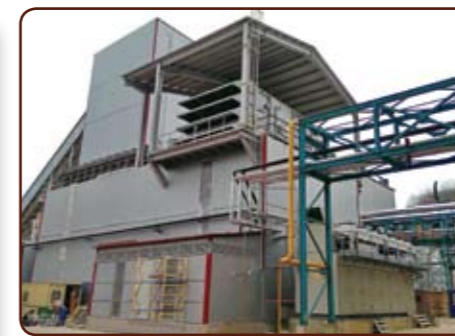
Рис. 9. Автономный центр энергоснабжения завода Kastamonu – ГТУ-ТЭС мощностью 25 МВт
