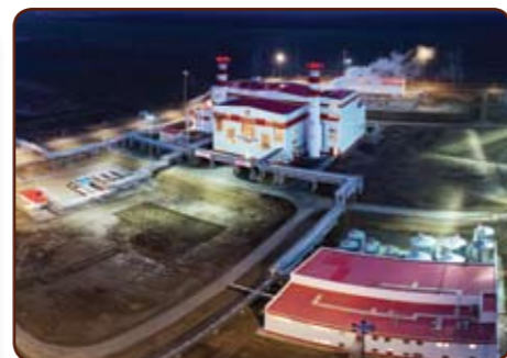
Рис. 2. Буденновская ПГУ-ТЭС обеспечивает энергоснабжение газохимического комплекса «Ставролен»
