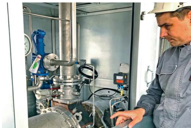
Фото 6. Собственные испытания оборудования завершают этап пусконаладочных работ
