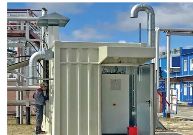
Фото 5. Отсек системы автоматизированного управления интегрирован в модуль установки
