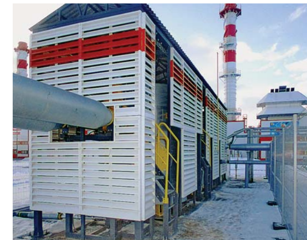
Фото 1. БППГ «ЭНЕРГАЗ» для энергоцентра собственных нужд ООО «ЛУКОЙЛ-Коми» (ГТУ-ТЭЦ, Усинское месторождение)
