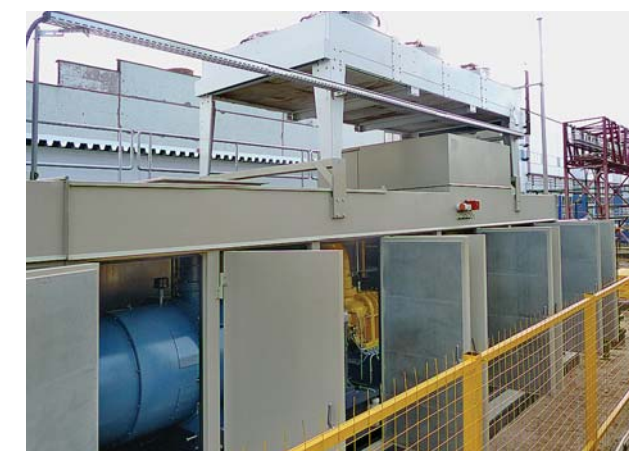
Фото 3. ДКС снабжает топливом испытываемые турбины и газоперекачивающие агрегаты
