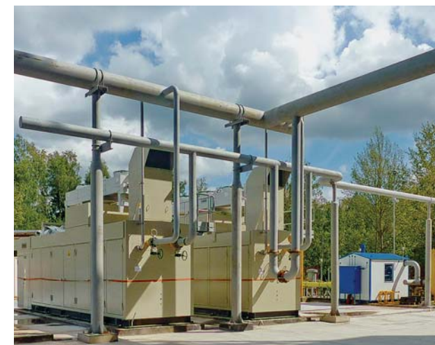
Фото 11. Система газоподготовки «ЭНЕРГАЗ» для автономной ГПЭС завода микроэлектроники «Ангстрем-Т»
