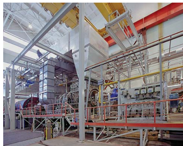
Фото 6. Испытательный цех «Невского завода»
