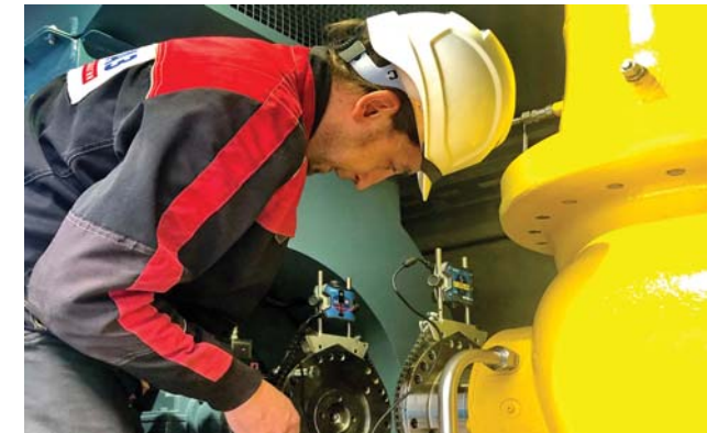
Фото 8. Комплексный ввод оборудования выполнили специалисты компании СервисЭНЕРГАЗ
