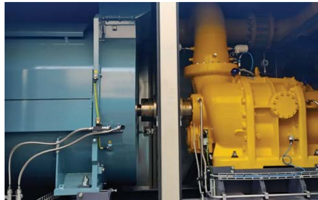
Фото 3. Основа ДКС-2 – винтовой компрессор с электродвигателем
