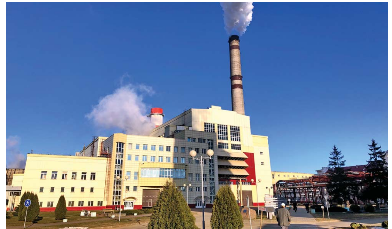
Фото 1. Парогазовый энергоблок ПГУ-230 Минской ТЭЦ-3
