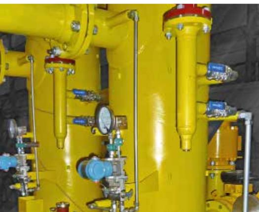
Фото 5. Двухступенчатые коалесцирующие фильтры-сепараторы
