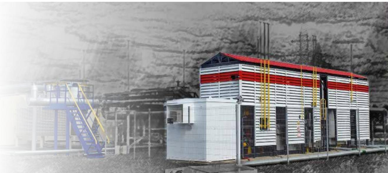
Фото 9. Блок подготовки попутного газа для ГТУ-ТЭЦ Усинского месторождения
