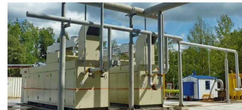
Фото 12. Система газоподготовки для автономной ГПЭС завода микроэлектроники «Ангстрем-Т»
