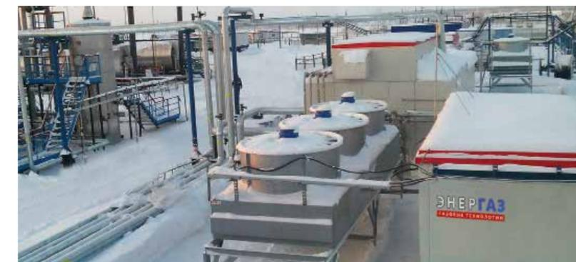
Фото 11. Комплекс оборудования для подготовки попутного газа на ЦПС Западно-Могутлорского месторождения
