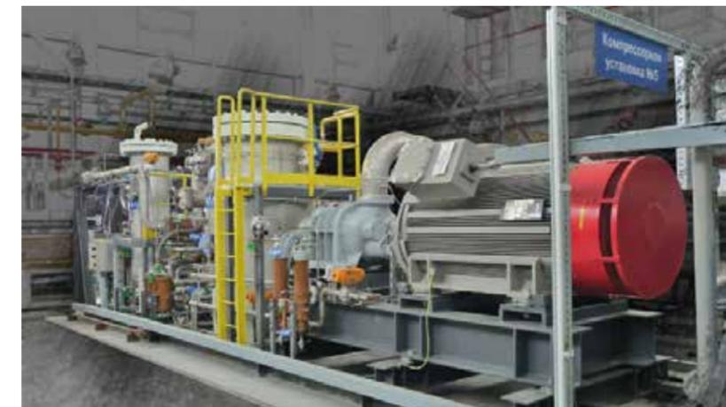
Фото 2. Технологический отсек блочного пункта подготовки газа
